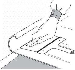
**10 Arraser** le débord du revêtement de sol à l'aide d'un cutter et d'une spatule sans détériorer le matériau amianté
